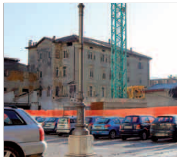
Il cantiere in piazza delle Erbe (FOTO Longo)
