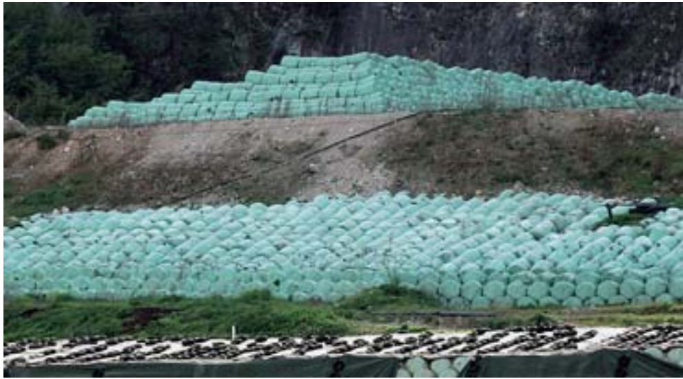
Trento nord L'inceneritore sarà costruito al posto della discarica di Ischia Podetti (Foto Rensi)
