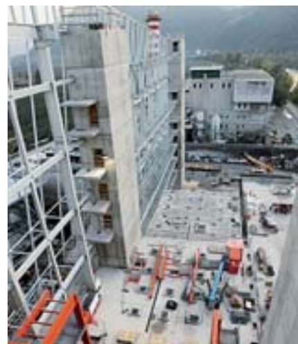
Dall'alto L'area del cantiere
