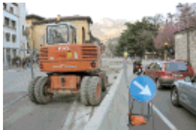
Il cantiere aperto ieri in via San Francesco d'Assisi (foto Panato)
