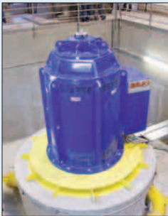
A fianco, il rio Bondal, in località Moline, dove la protesta ha bloccato il progetto di centrale idroelettrica del Consorzio elettrico di Stenico. In alto, a sinistra, la turbina nella centrale idroelettrica di Pellizzano sul rio Fazon
