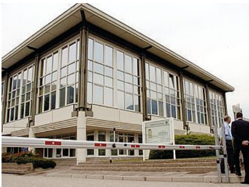
La sede dell'Autobrennero in via Berlino
